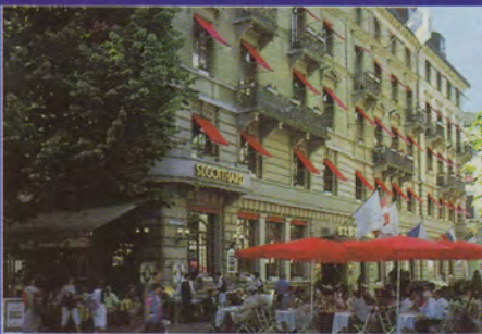
Hotel in Zürich: Rostproblem
