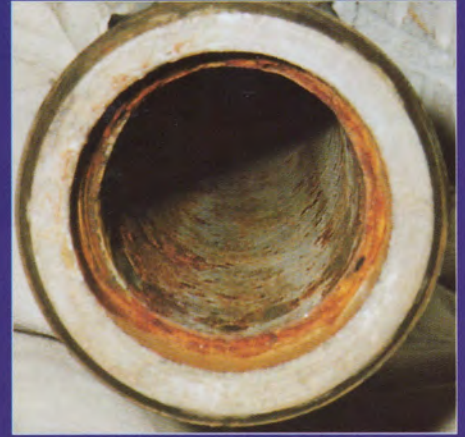
Heisswasserleitung nach 12 Monaten: Perfekt saniert
