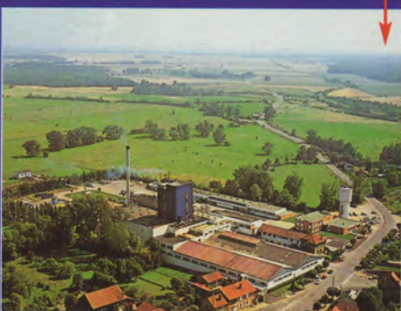
Mehrfamilienhaus, Industrie-, Gewerbe- und Verwaltungsbauten usw. (Foto Nestlé)
