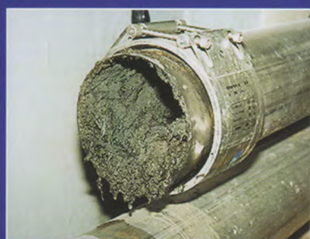
Sickerleitung Kläranlage
