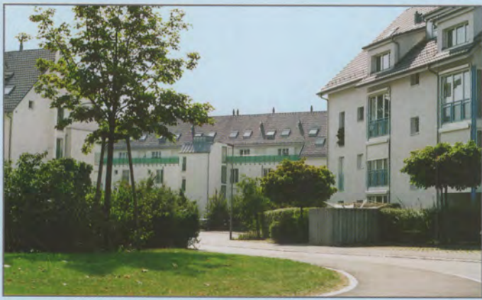
Mehrfamilienhäuser: Ein Grossgerät
