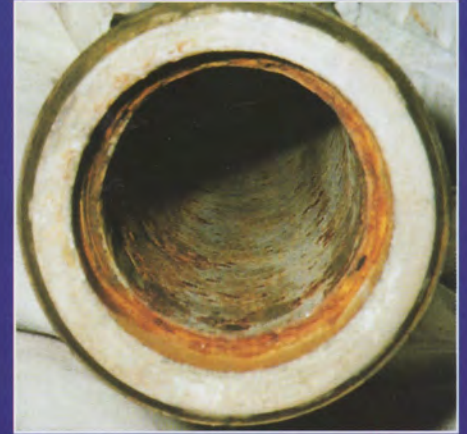
Heisswasserleitung nach 12 Monaten: Perfekt saniert
