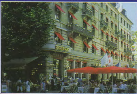
Hotel in Zürich: Rostproblem
