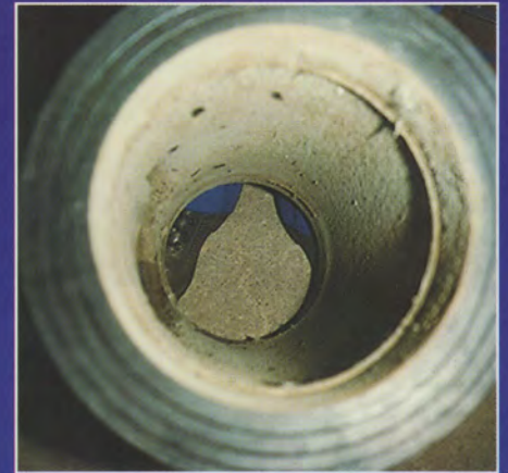
ARA-Sickerleitung nach 12 Monaten: 12" Leitung kalkfrei
